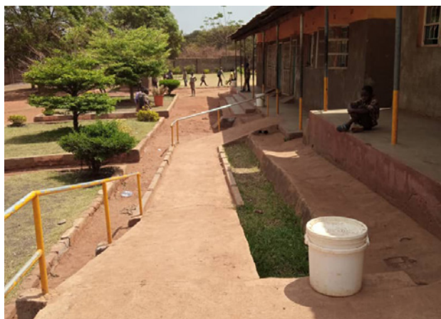
La educación inclusiva requiere que la escuela sea accesible para todos. Gracias a la relación continuada con actores principales externos, se construyeron rampas y pasamanos.
